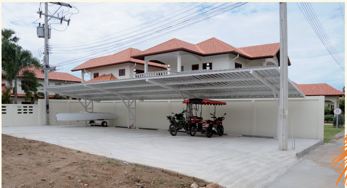
Fiks ferdig garasjeanlegg med tykk betongsåle og ferdig pusset mur.
